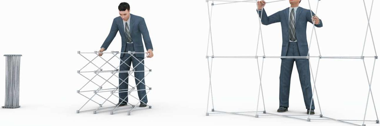
2.2. Не прилагая чрезмерных усилий, отсоедините ребро жесткости от общей пачки (ребра уложены в компактный блок для транспортировки и примагничиваются друг к другу). Обратите внимание на то, как были уложены ребра в чехол, это понадобится при разборке стендса)
